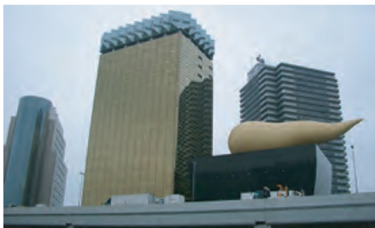
創立100周年を記念して平成元年に隅田川沿いに建てられた本社ビル。建物はビールのジョッキをイメージ。巨大なオブジェは著名な仏人デザイナー、フリップ・スタルクが設計。21世紀を目指す精神を聖火台の炎として表現したもののだが、当時から「他のもの」を想像すると話題に――。
